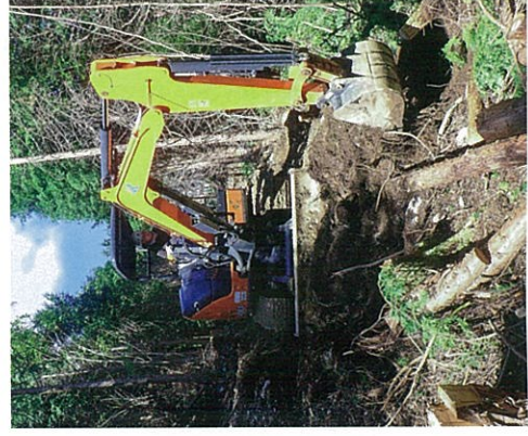
作業道開設の実習。森林の整備・管理を行うために必要な道だ
